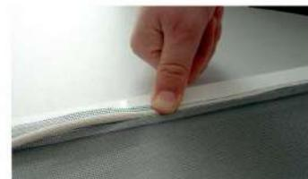
Разложите сетку ровно по раме. С помощью уплотнительного шнура закрепите полотно сетки в паз рамного профиля. Крепить шнур лучше от угла. Полотно сетки не должно провисать.
