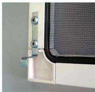
К нижней части внутренней стороны москитной сетки приложите 2 металлических кронштейна (коротких) и отметьте места для сверления под крепеж (по 2 с каждой стороны). С помощью дрели просверлите отверстия в рамном профиле и прикрутите крепления.
